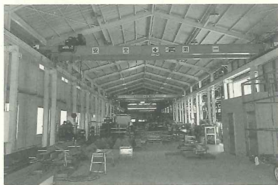
工場一部を改築
